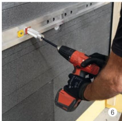
Forare con una punta multifunzione / per perforatore a seconda del tipo di supporto. Diametro di 10 mm e profondità minima di 110 mm. Soffiare nel foro.
