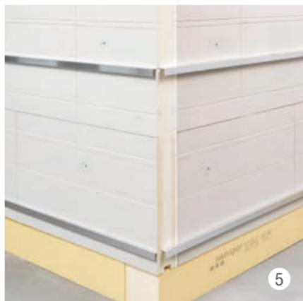
Incastrare Vento Angolo in alluminio 29/40 nell'apposito intaglio orizzontale creato nell'isolamento (lato da 40 mm all'interno nell'isolamento).
