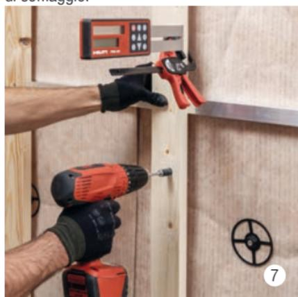
Posizionare la sottostruttura per mezzo di un laser rotativo e del relativo supporto e fissarla saldamente a vite al supporto di posa. Non sarà più possibile spostarla!
