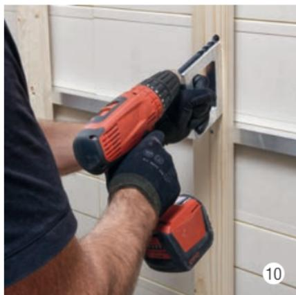
Forare il supporto con una punta multifunzione / per perforatore a seconda del tipo di supporto e co l'ausilio della dima di perforazione Vento. Foro 15° verso l'alto e diametro di 10 mm. Pulire con pompa di soffiaggio.
