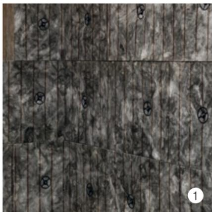
Tagliare precisamente i pannelli isolanti con un dispositivo di taglio adatto. Posare le lastre isolanti con giunti sfalsati dal basso verso l'alto.
