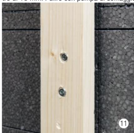
Disporre il raccordo a vite sfalsato di circa 5 mm (venatura del legno) e ad una distanza orizzontale di 70 mm.
