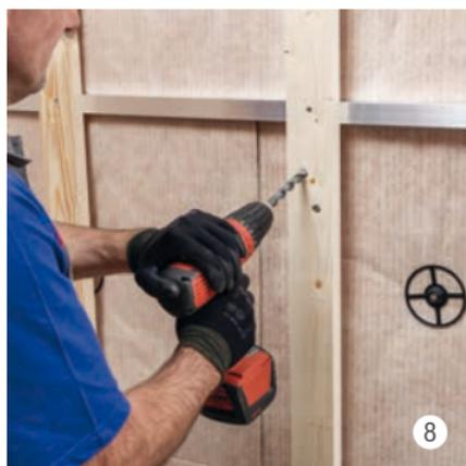
Trapanare attraverso la listonatura con una punta elicoidale HSS legno-alu da 11,5 mm. Foro a 15° verso l'alto.
