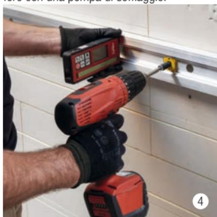
Posizionare la vite distanziale Vento fino al punto d'arresto e pre-avvitare al supporto. Allineare con l'ausilio di un laser rotativo e fissare saldamente.
